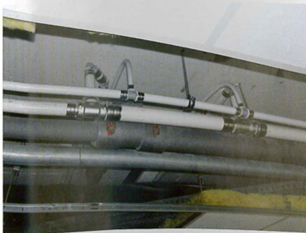
Obrázky ukazujú možnosť moderného a zároveň cenovo prijateľného riešenia aplikácie rozvodov studenej a teplej vody + cirkulácie až do dimenzie s priemerom D 110 mm (systém Udonor MLC Riser)
