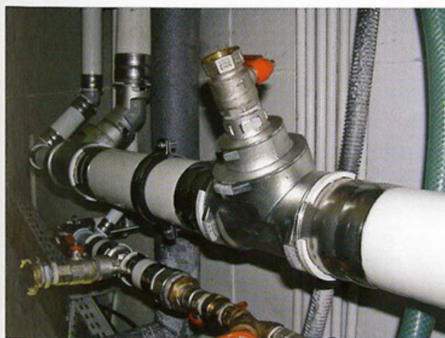
Obrázky ukazujú možnosť moderného a zároveň cenovo prijateľného riešenia aplikácie rozvodov studenej a teplej vody + cirkulácie až do dimenzie s priemerom D 110 mm (systém Udonor MLC Riser)
